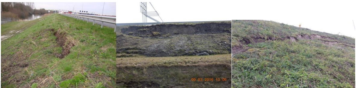
Foto: Afschuiving van talud.
